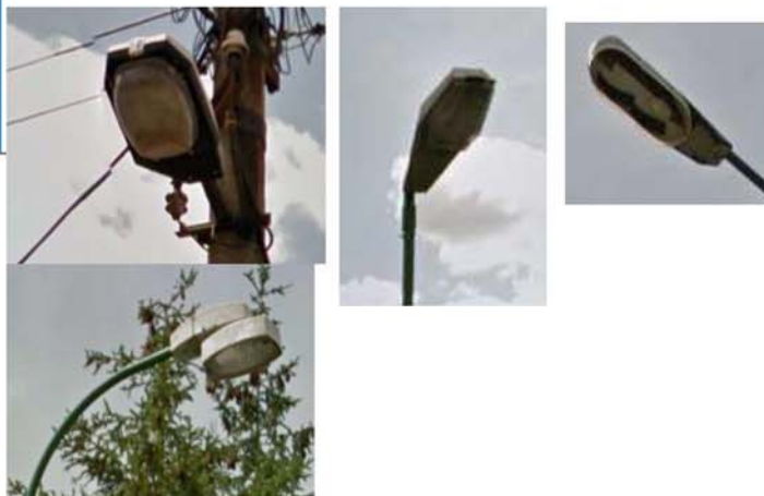
Svietidlá PRED rekonštrukciou
